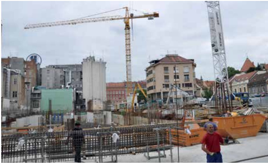
Sl. 147 Izgradnja Ban centra, 2011.
